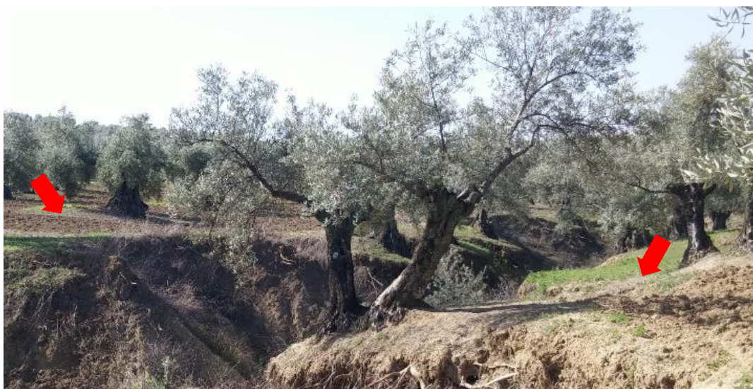
Figura 10. Laboreo convencional tradicional. Se observa el efecto de las labores según la línea de máxima pendiente al borde de los olivos cercanos a deslizarse al fondo de la cárcava.
